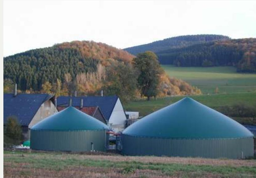
Nach der Erweiterung auf eine elektrische Leistung von **190 kW** wird sie heute mit jährlich 3.600 t Rindermist, 2.200 t Schweinegülle und 1.200 t Maissilage gefüttert
