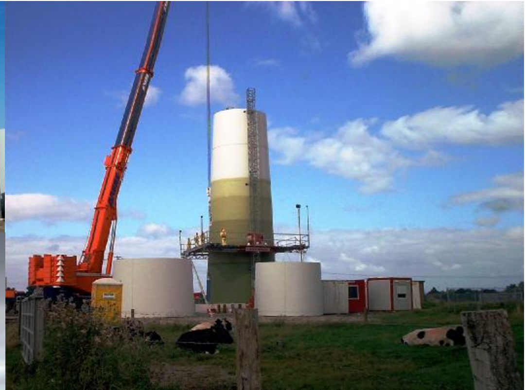
Montage des Prototyps E-82 in Deutschland – mit einem Fertigteilbetonturm
